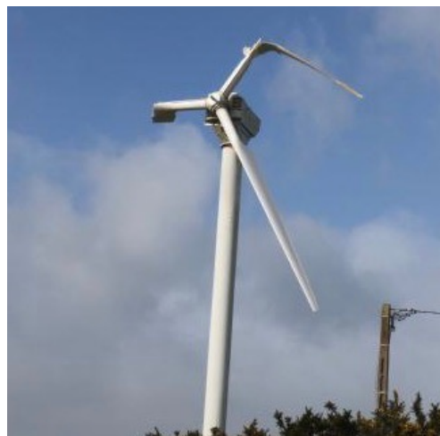
Pales brisées par un coup de vent en février 2016 à Dinéault, dans le Finistère.
