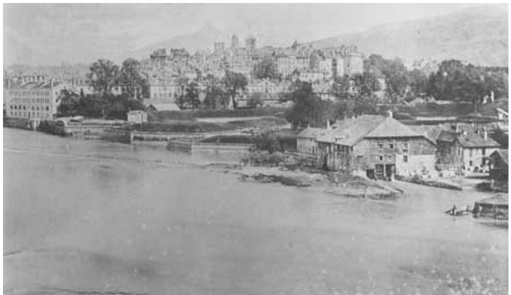
Moulin Pelaz à la Coulouvrenière en 1875
