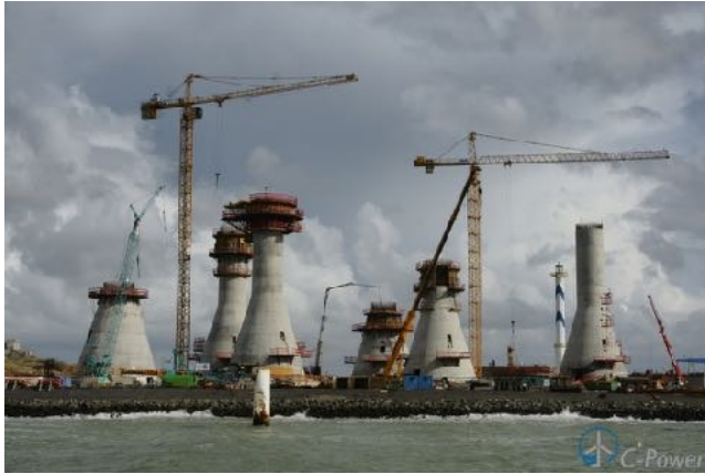
Construction à terre d'une fondation gravitaire
