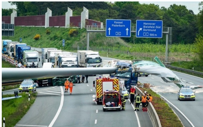
Effondrement d'une éolienne sur une autoroute allemande près de Bielefeld le 17 mai 2017.
