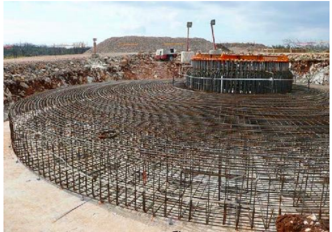
Le ferrailage des fondations est important. Il assure la cohésion de la masse de béton qui sera coulée et l'ancrage de la virole au centre.
