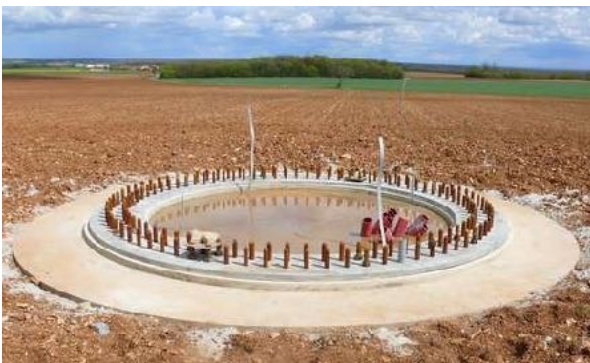
Partie supérieure de la virole prête à recevoir la première section du mât.
