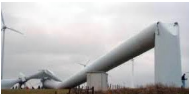
Chute d'une éolienne au Canada
