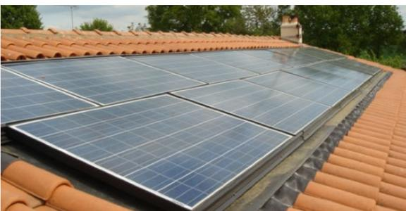
*Les panneaux photovoltaïques transforment directement l'énergie solaire en courant continu. Le rendement est assez faible et n'atteint guère que 12% de l'énergie solaire reçue. Le coût du kWh obtenu est encore très supérieur à celui des autres sources d'électricité. La production est directement*
