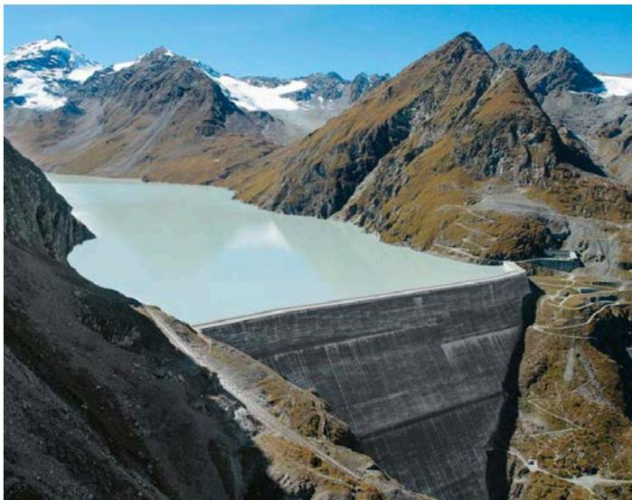
*Barrage de la Grande Dixence, situé dans le Valais, sa hauteur est de 285 m, il contient 400 millions de m<sup>3</sup> d'eau. La puissance installée est de 2'000 MW.*
