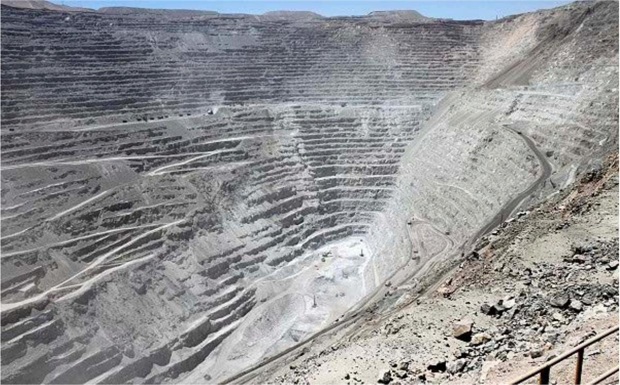
*Mine de cuivre de Chuquibambilla dans le nord du Chili. Cette carrière géante mesure 5 km de longueur, 3 kilomètres de largeur et 950 mètres de profondeur. La hauteur de chaque gradin est de 22 mètres ! Elle assure 14% de la production mondiale de cuivre.*
