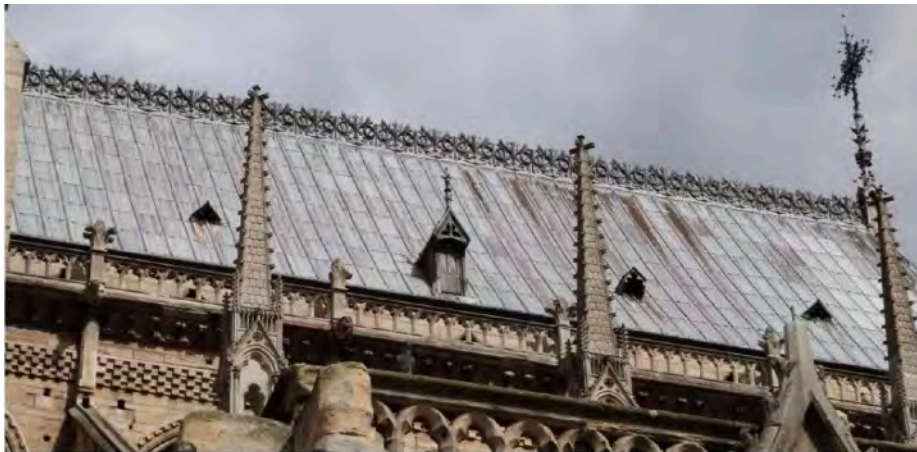
Toiture de Notre Dame de Paris.
