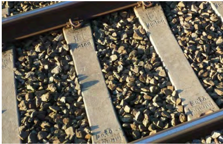
Ballast de chemin de fer constitué de granulats entre 20 et 63 mm
