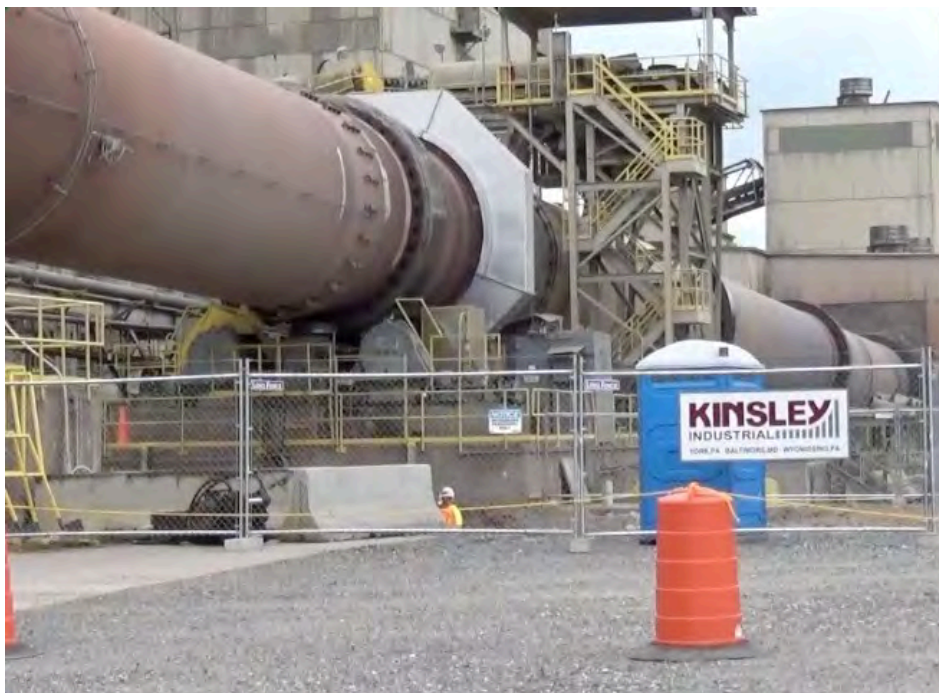
Four à ciment de plus de 150 mètres de long à Hagerstown (Maryland,
