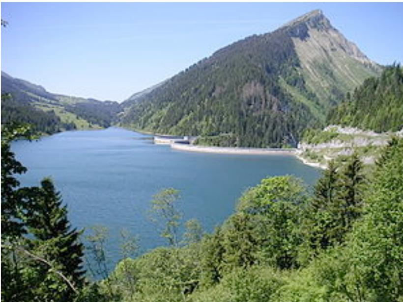
*Mais la tendance actuelle est d'utiliser cette énergie nocturne excédentaire pour remonter l'eau d'un bassin d'accumulation au moyen de pompes puissantes, vers un autre bassin situé à plus haute altitude. C'est une manière indirecte de stocker l'électricité sous forme d'énergie potentielle. Cette technique n'est possible que dans les régions de montagnes où existent déjà des installations hydroélectriques.*
