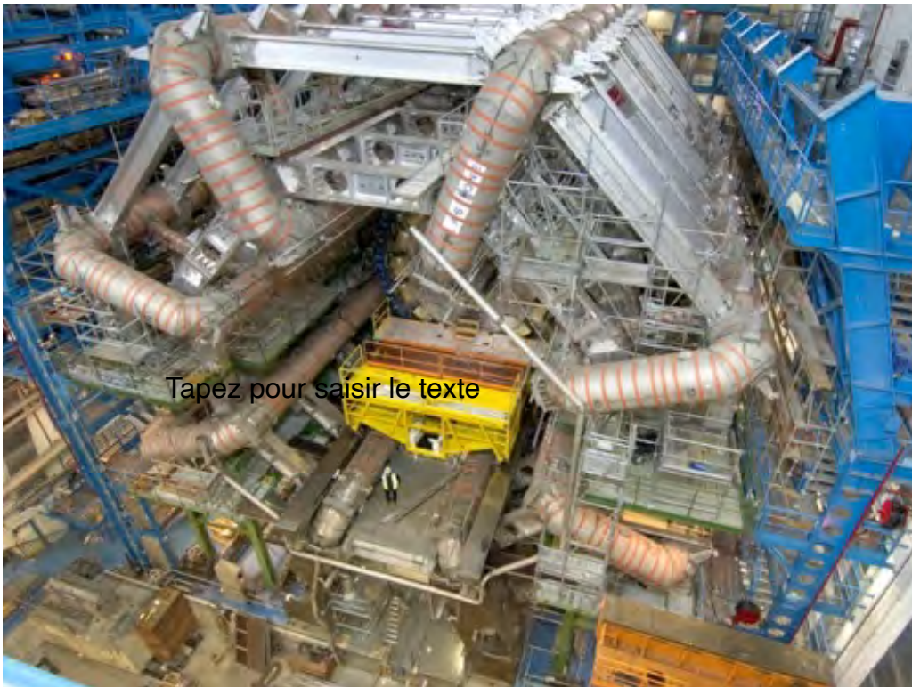
ATLAS en cours de construction.
