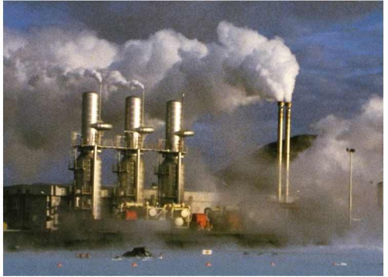
Production d'électricité grâce à des captages de vapeur à haute température, Keflavik, Islande.
